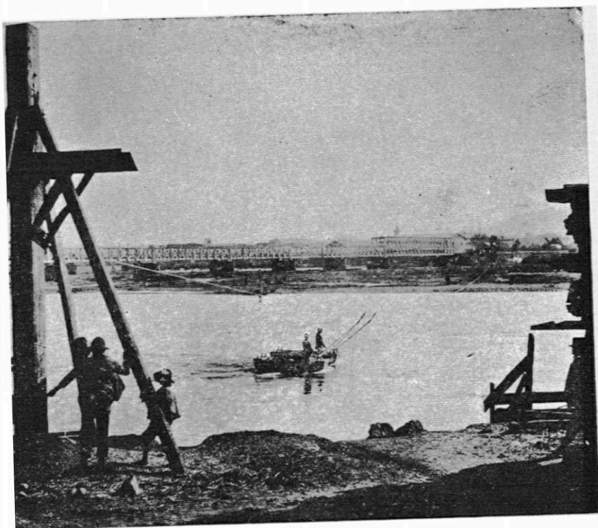
Fig. 31.—Sección de aforo del río Cautín en Temuco.—Botes de aforo.
