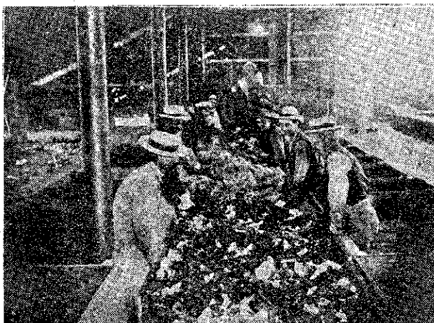
Selección de las partes útiles de la basura por medio de una cinta sin fin.
