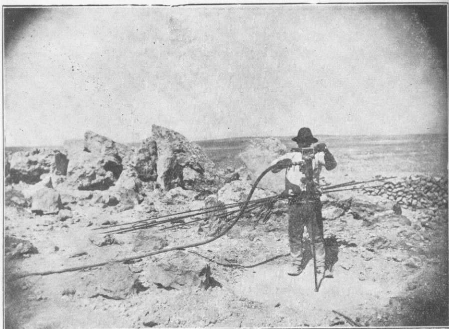
Perforación mecánica de la pampa
