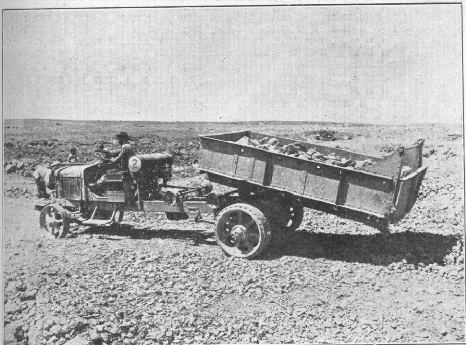
Transporte mecánico del caliche
